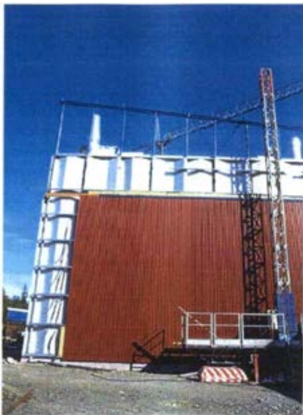
Figur 1. Rostfri kammartork under uppförande.
